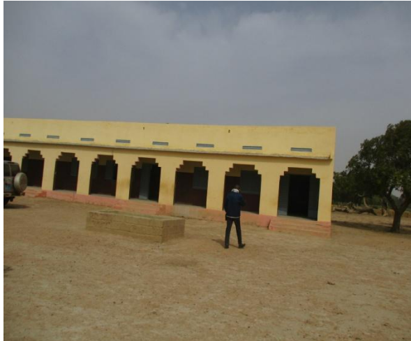
L'école de 03 classes construites à Tako dans le cadre des mesures d'accompagnement
