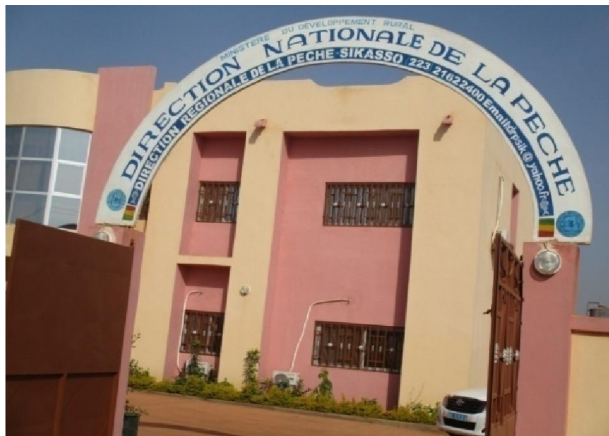
Nouveaux bureaux de la DRP de Sikasso
