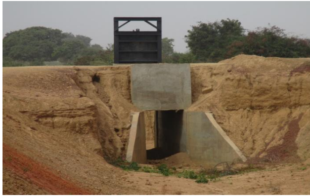
Ouverture du canal de drainage des eaux
