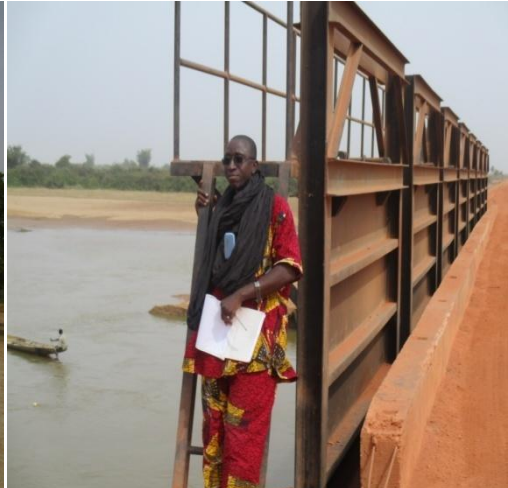
Ouvrage de vidange du casier sud de Pondori
