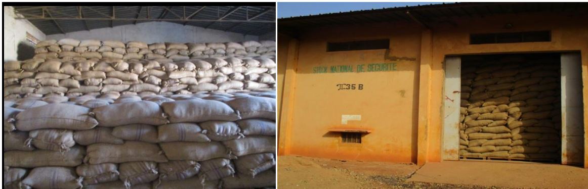
Magasins contenant de stock de sécurité à Koutiala
