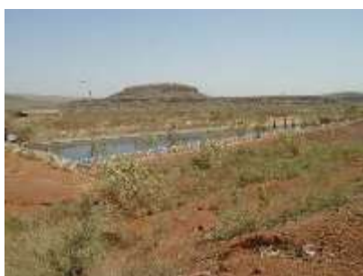
Vue du bassin de rétention de la cellule
