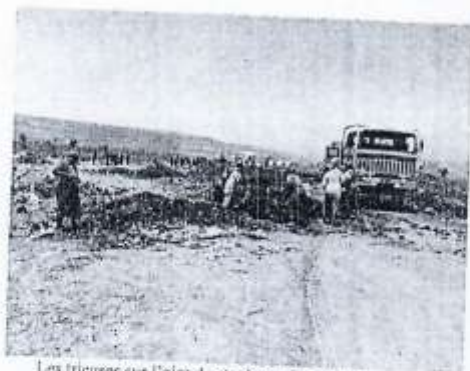
Les tricuses sur l'aire de stockage des ordures
