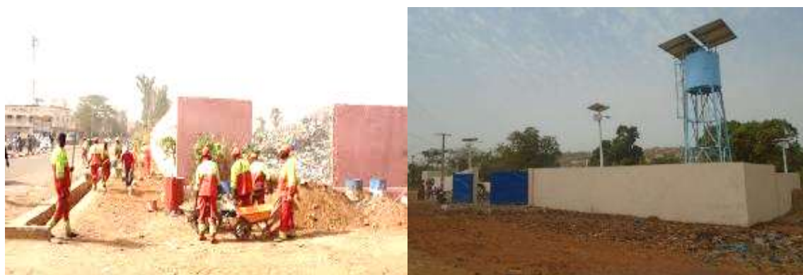
Dépôt de transit de Lafiabougou après les travaux en début Janvier 2020
