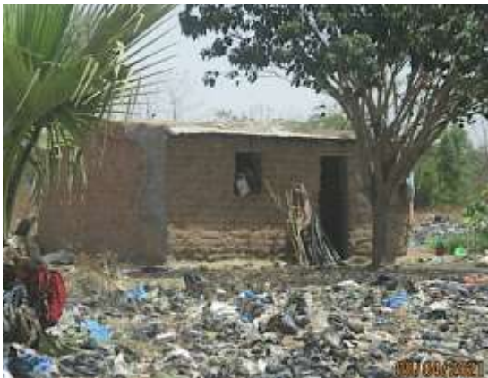
Figure 31 Bâtiment isolé en banco dans un champ
